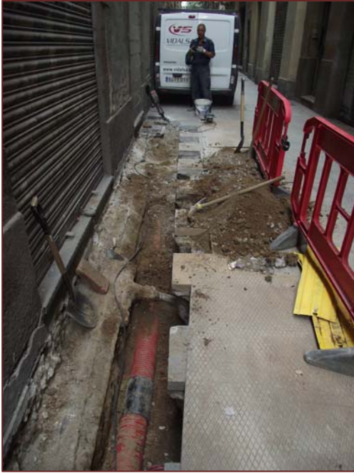
Foto 005: Vista dels serveis ja instal·lats.
