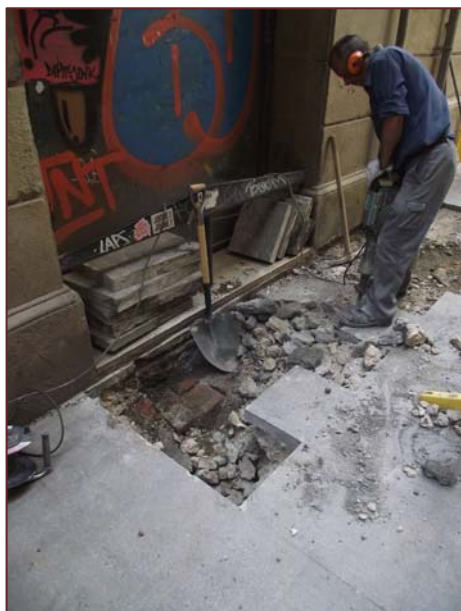
Foto 003: Obertura de la rasa amb martell elèctric.
