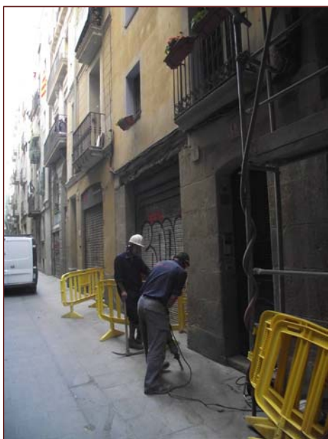
Foto 001: Obertura de la cala 1 al carrer d'Estruc.
